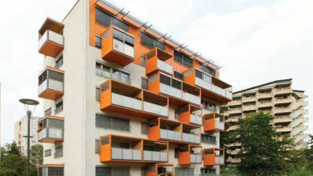
27 oskrbovanih stanovanj na Kajuhovi ulici 15 v Celju
